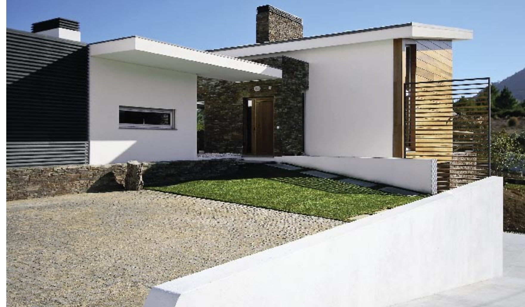
➤ "Depois de passar um corpo branco rematado por uma estrutura em grelha, somos encaminhados pela pala que nos protege e direcciona à entrada"
