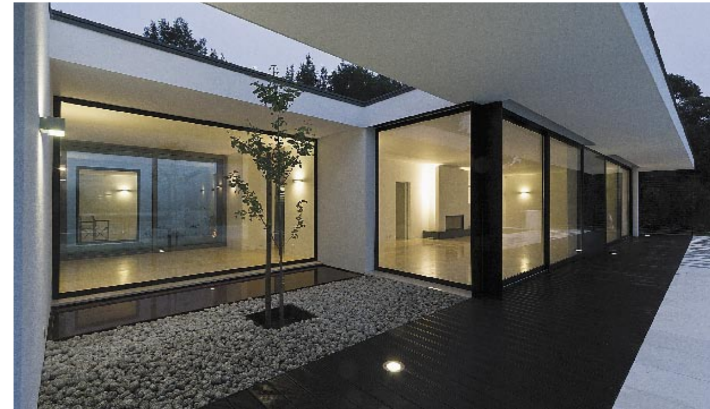
Os arquitetos aproveitaram o desnível do terreno para criar o efeito de fusão da habitação com a envolvente, recorrendo às coberturas ajardinadas
